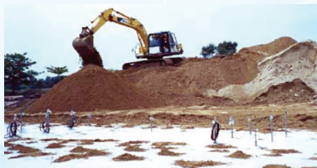
Damm auf weichem Boden: Vertikaldrainage und Basisbewehrung
