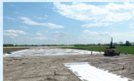
Geokunststoffbewehrter Damm auf weichem Boden
