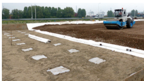
Bewehrung über Pfählen mit hochzugfesten Geogeweben
