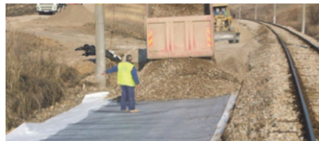
使用土工織布-土工格網之土工複合材料直接鋪設於軟弱路基上，可提供分隔、過濾和穩固效果
