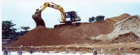
Κατασκευή επιχώματων επί μαλακών εδαφών: κατακόρυφα στραγγιστήρια και οπλισμός της βάσης
