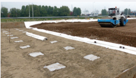
Οπλισή πάνω από την κεφαλή των πασσάλων, με γεωσυνθετικά υλικά υψηλής αντοχής
