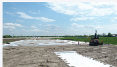
Παράδειγμα γεωσυνθετικών που ενισχύουν το επίχωμα επί μαλακού εδάφους
