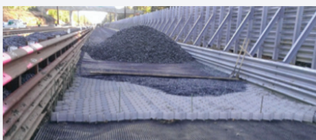
Συνδυασμένη χρήση γεωκυψελών, γεωπλεγμάτων και Μη-υφαντών γεωυφασμάτων για τη σταθεροποίηση σιδηροδρομικών γραμμών
