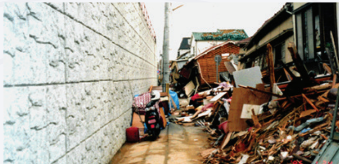
Σχήμα 2 Τοίχος ενισχυμένου εδάφους κατά τη διάρκεια του σεισμού του Kobe (Tatsuoka et al: S&F, 1996)
