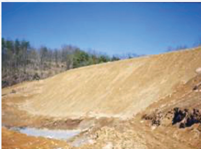
Οπλισμένο επίχωμα μετά την ολοκλήρωση της κατασκευής του
