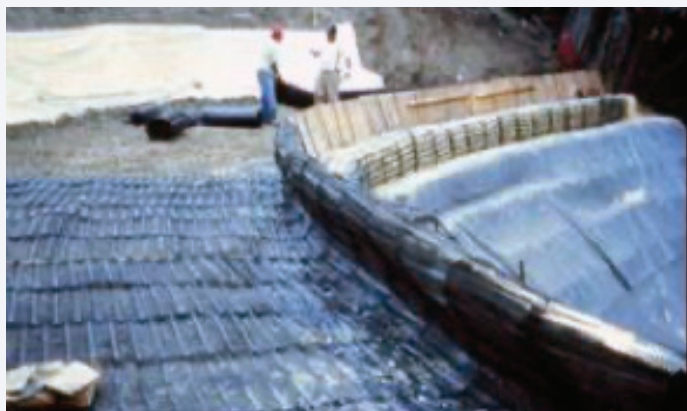
Παράδειγμα αποκατάστασης πρανού με όπλιση της διαμορφωμένης με επίχωση παρειάς του
