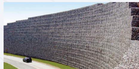
Αποψη στοιχείων όψης λιθοπληρωμένων συρματοκιβωτίων
