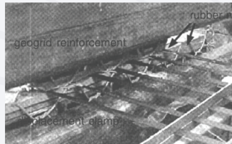
Δοκιμή εξόλκευσης γεωσυνθετικού - συρματοκιβωτίου
