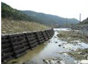
聚乙烯块材护坡
