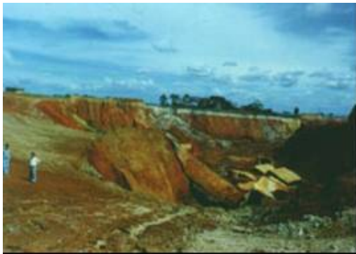
冲刷引起的破坏
