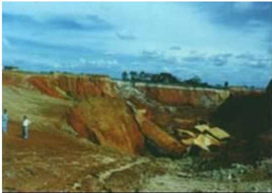
Разрушения, вызванные эрозией
