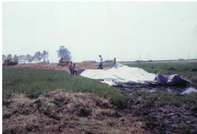
Construirea unui drum nepavat armat, pe argila organică moale
