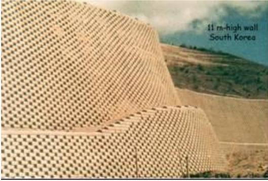
Подпорная стена с модульной бетонной облицовкой
