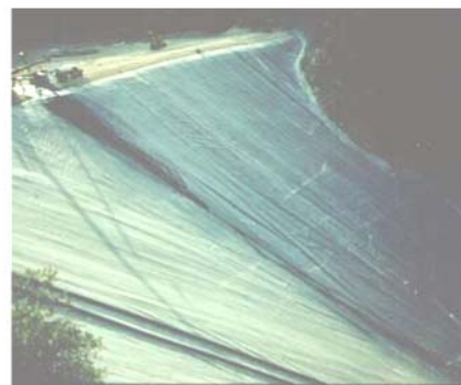
Etanchement d'un barrage par géomembrane*
