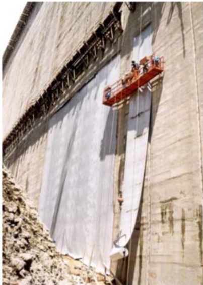
Etanchement du parement amont d'un barrage*
