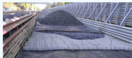
Uso combinado de geoceldas, geomallas y geotextiles no tejidos para estabilizar vías férreas
