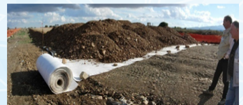
Instalación de un geocompuesto drenante en la base del terraplén ferroviario. En este caso el GCD está instalado en el terraplén
