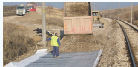
Geotextil - geocompuesto de geomalla colocado directamente en la subrasante blanda para proporcionar separación, filtración y estabilización
