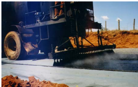
Géosynthétiques dans la construction d'une chaussée (*)
