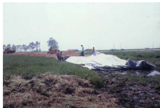
Construction d'une route non revêtue sur une argile organique molle
