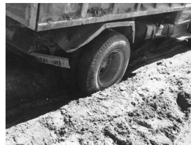
Mécanismes typiques de dégradation des routes non revêtues et non renforcées sur les sols mous
