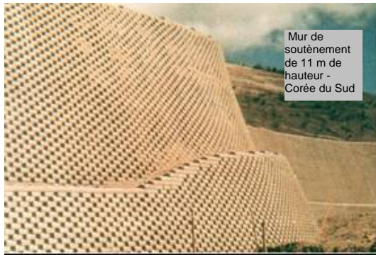
Massif à parement en blocs en béton
