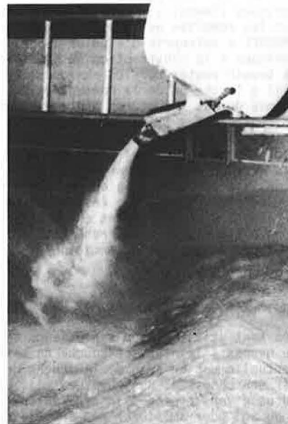
Fig. 4 : Mise en oeuvre du Texsol
