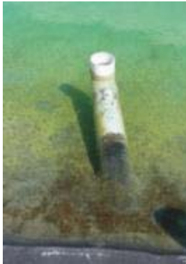
Fig. 36 Pipe spillway
