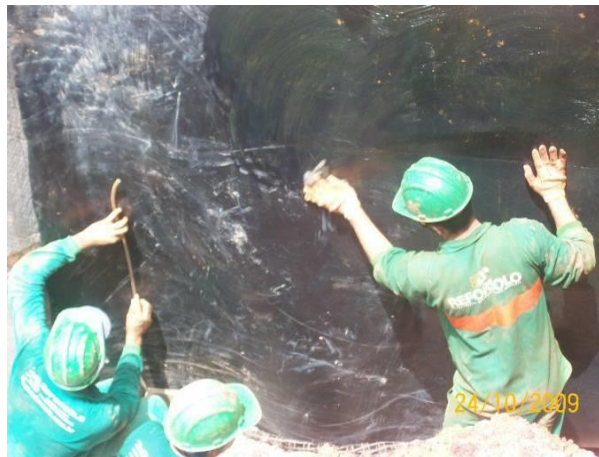
Figura 13. Aplicação de graxa na geomembrana de PEAD disposta verticalmente.
