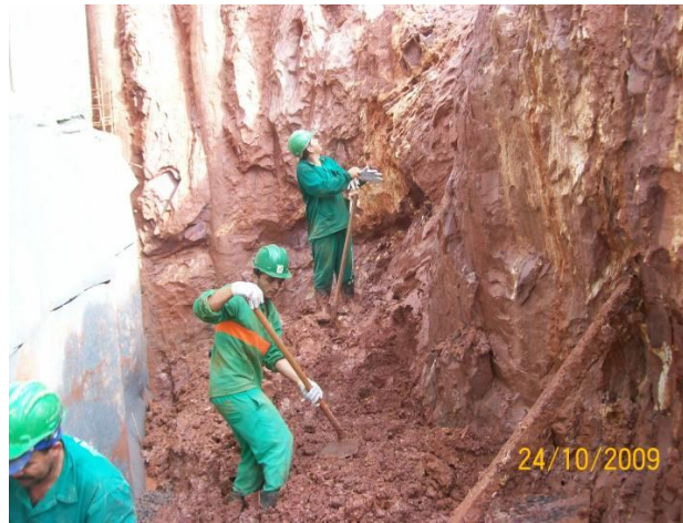
Figura 12. Remoção de terra e regularização da área utilizada para a construção do protótipo.
