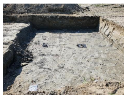
(d) Buried detecting material (1.0m depth)
