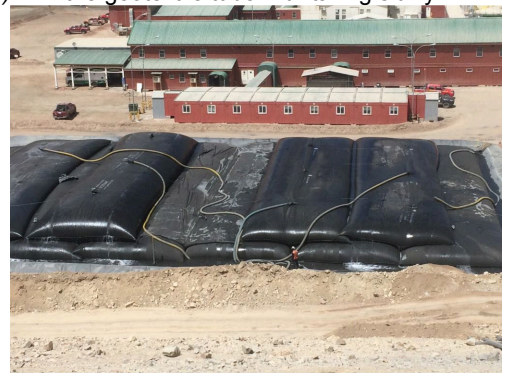
(d) Stacking geotextile tube
