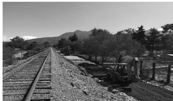
Figura 13. Colocación de material de terraplén
