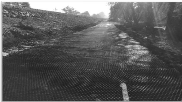
Figura 12. Colocación de gemalla multiaxial
