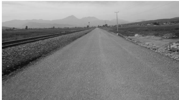
Figura 10. Colocación de capa de sub-balasto
