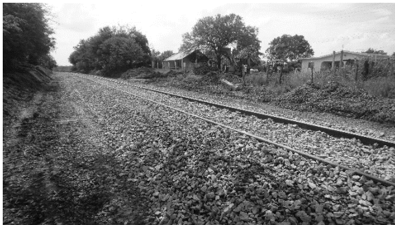
Figura 6. Balasto compactado
