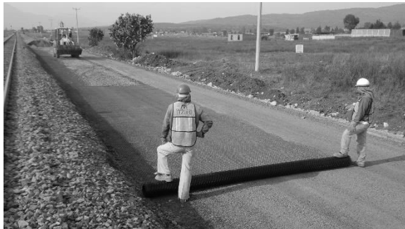
Figura 9. Colocación de geomalla multiaxial
