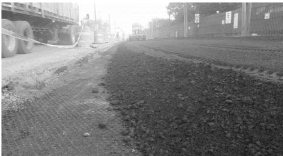
Figura 11. Colocación de capa de rodadura
