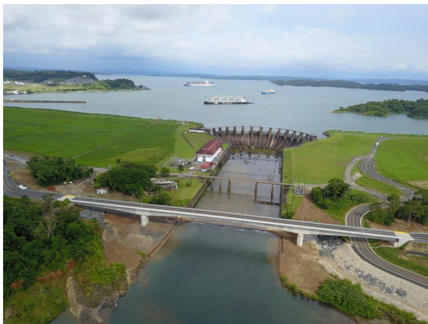
Figura 8. Puente terminado con los accesos en terraplenes de suelo reforzado con geotextil.
