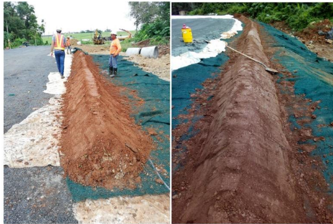
Figura 5. Colocación de bordes con suelo (Grupo Puente)
