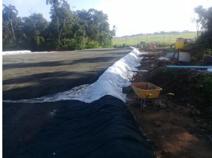
Figura 7. Relleno estructural contra suelo de borde revestido de manto (Grupo Puente)
