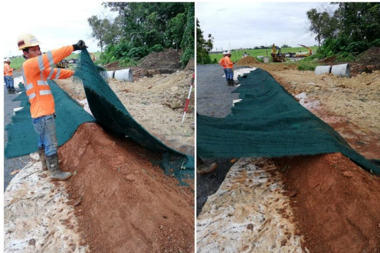
Figura 6. Colocación de manto para control de erosión (Grupo Puente)
