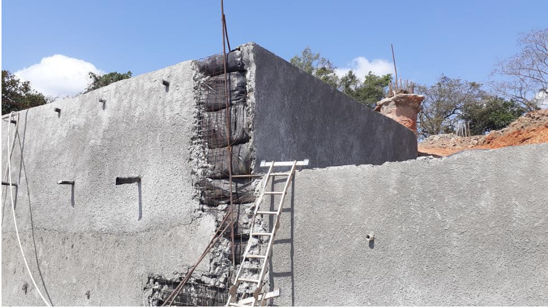
Figura 5. Imágenes del revestimiento de la fachada con mortero.
