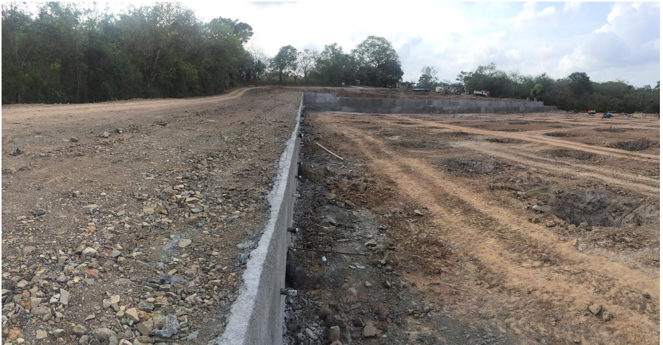
Figura 6. Imágenes del alineamiento de los muros terminados.
