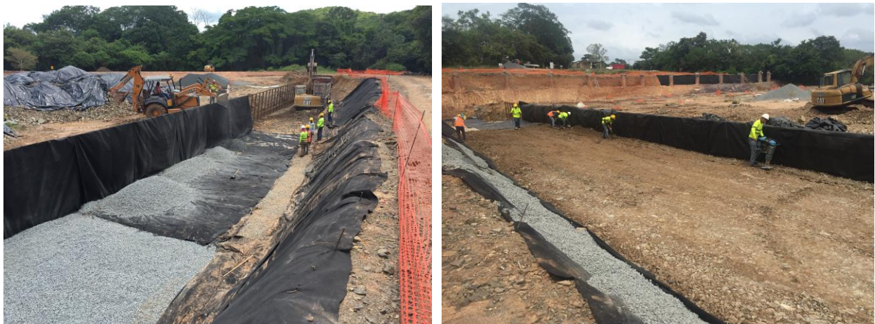
Figura 2. Construcción de elementos de drenaje en el fondo y espalda de los muros.
