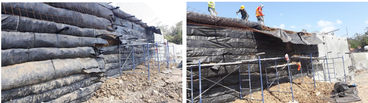
Figura 4. Imágenes del proceso de reparación de fachada.
