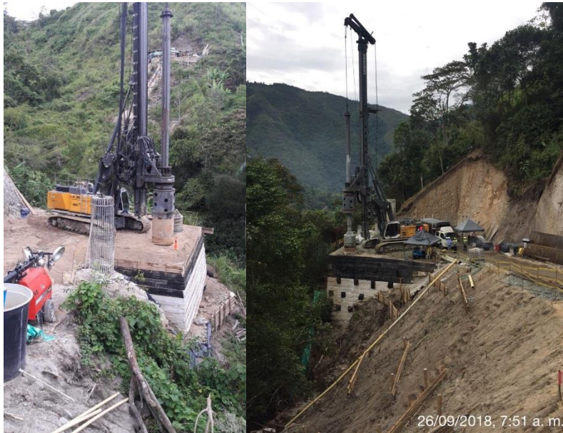
Figura 10. Proceso constructivo, Muros Columnas Puente 20.
