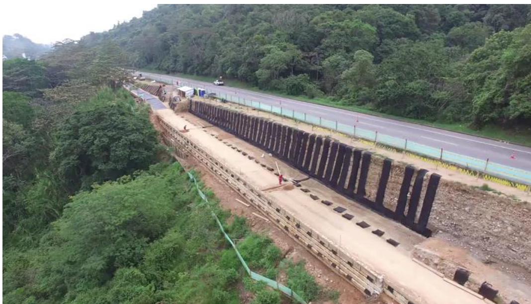
Figura 5. Proceso constructivo, Muro (8 y 9) K3+769 - K4+118).
