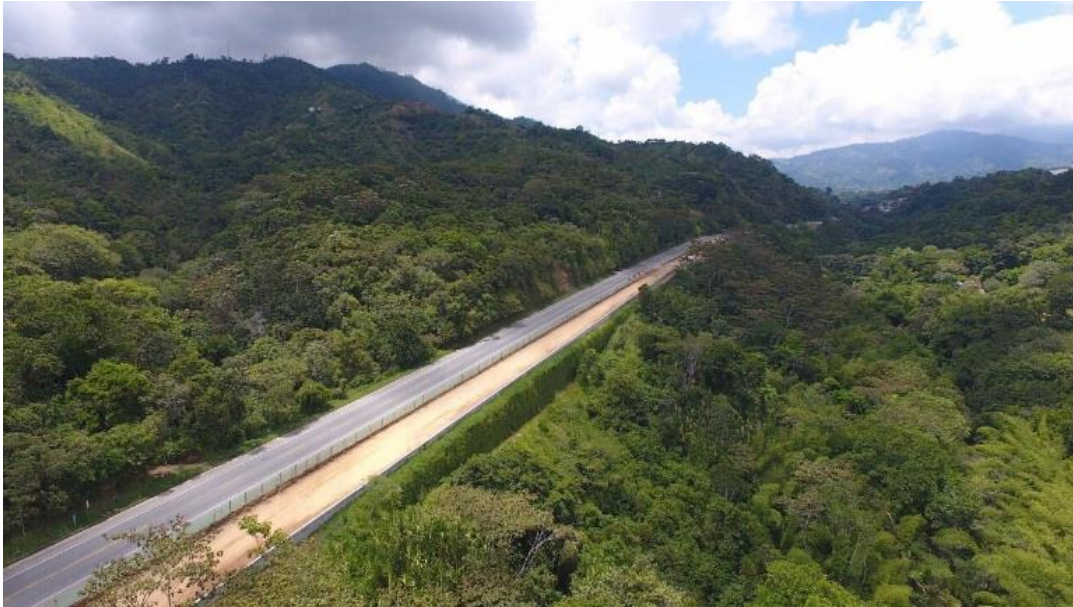
Figura 6. Resultado final, Muro (8 y 9) K3+769 - K4+118).
