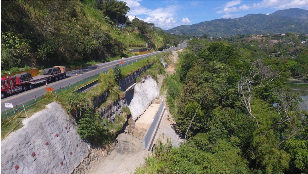
Figura 8. Proceso constructivo, Muro 22 K6+857 - K7+020.
