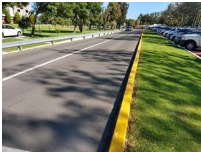
Figure 4. Tramo de deformaciones en la actualidad (octubre de 2019).
