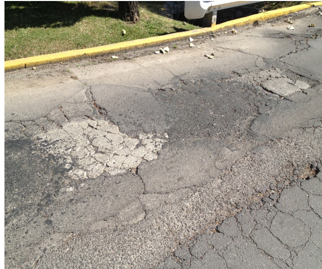
b) Bacheo y deformaciones
