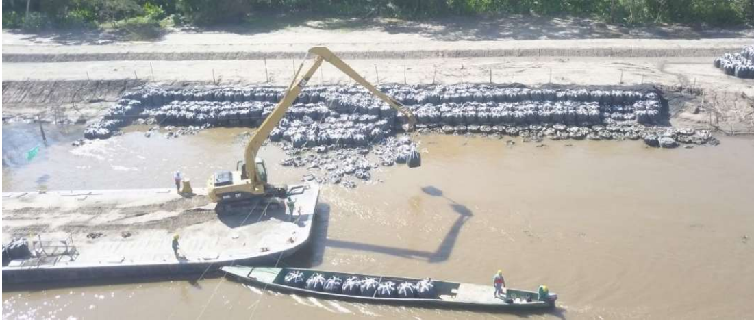
Ilustración 7: Instalación de Geobags en las estructuras.
