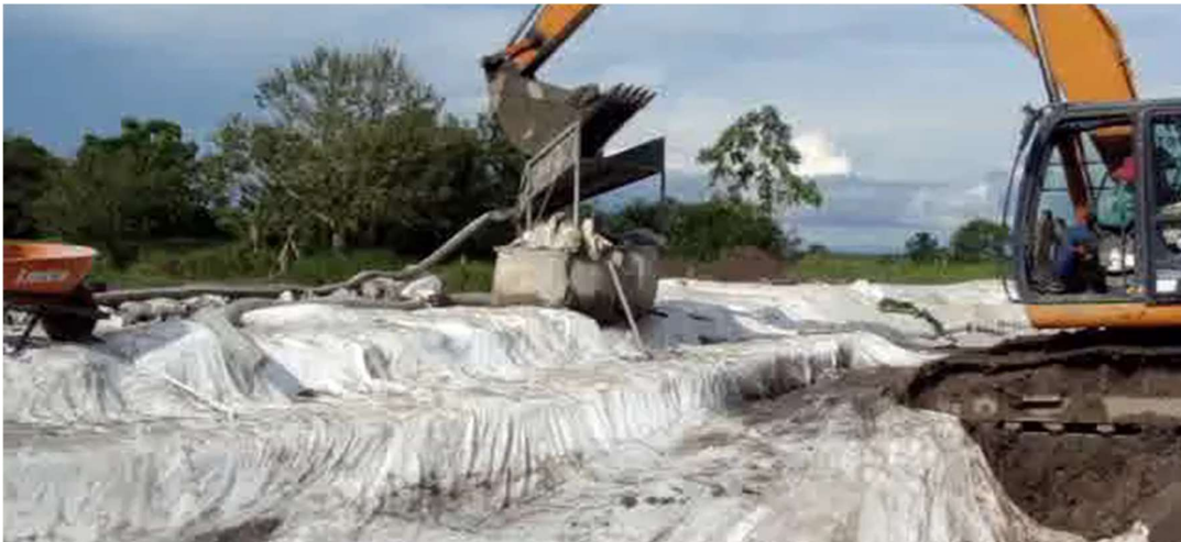
Ilustración 8: sistema de Formaleta Flexible lleno de concreto fluido.
