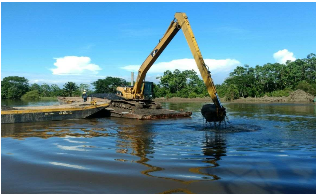
Ilustración 6: Excavación del lecho del caño San Silvestre.
