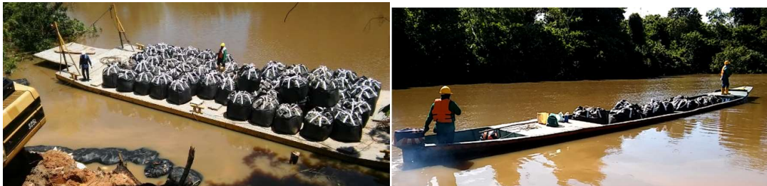
Ilustración 5: Transporte de Geobags.
