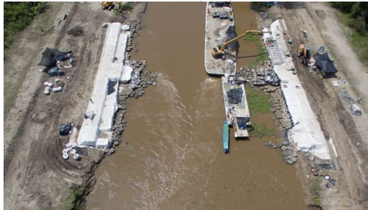
Ilustración 9: Diseño y construcción de la Estructura Caño San Silvestre.
