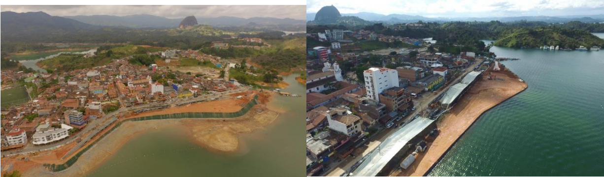
Figura 10. Vista general del proyecto terminado.
