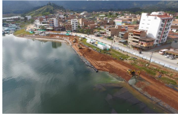
Figura 7. Conformación rellenos interiores.
