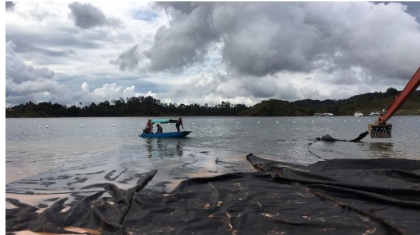
Figura 5. Instalación Geotextil como manto antisocavación.
