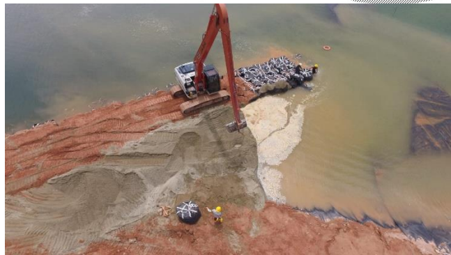
Figura 6. Conformación del dique exterior.
