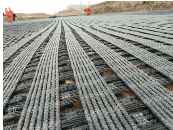
Figura 11 Traslape de Geomalla PVA de 1000kN/m
