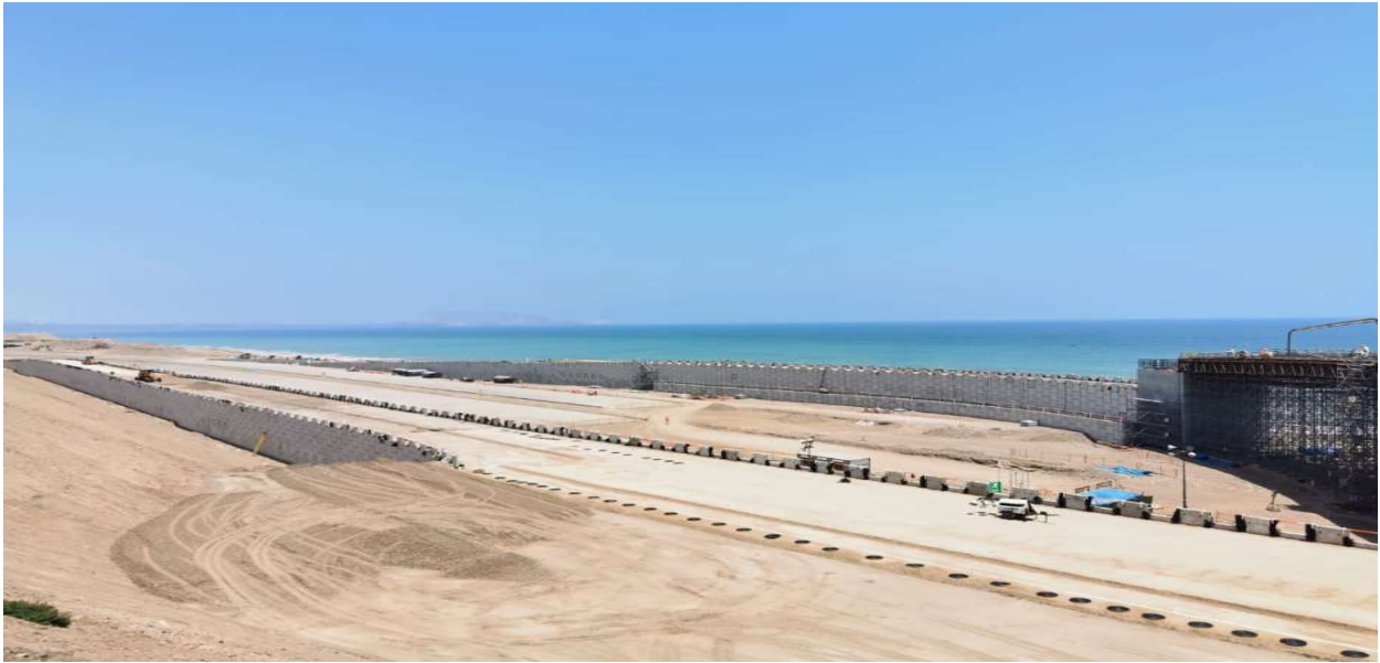
Figura 11 Muro de Suelo reforzado sobre plataforma de transferencia
