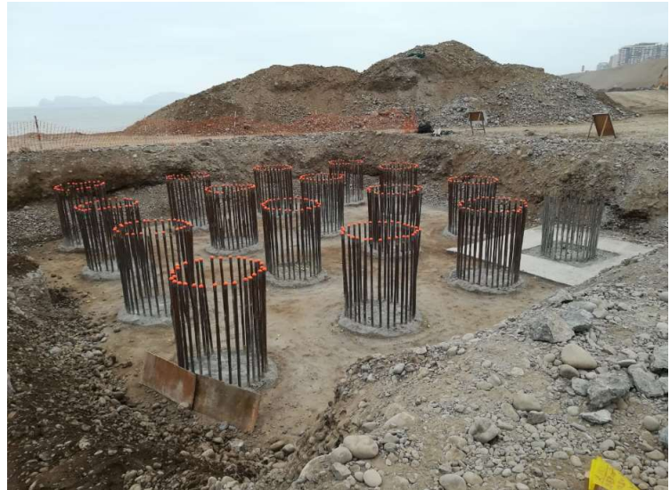
Figura 7. Pilotes en zona de Estribo
