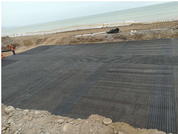
Figura 10 Tramo de prueba con geomallas PVA de 1000 kN/m
