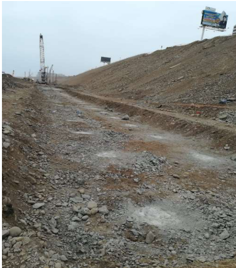
Figura 6. Pilotes en zona de rampa
