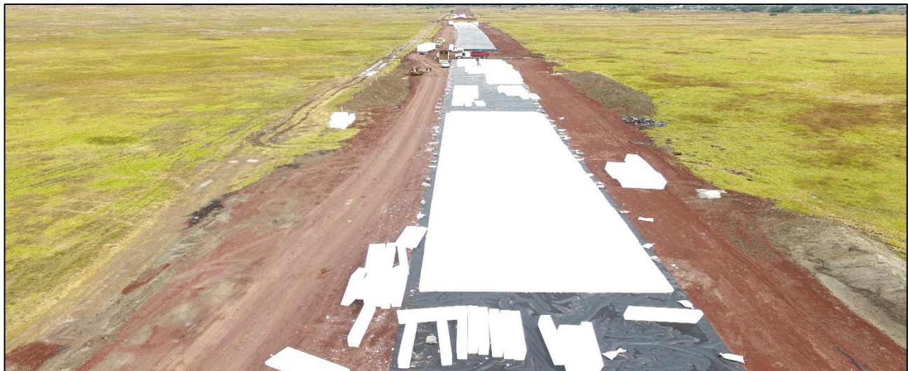
Figuras 13. Proceso de instalación de los bloques EPS cubiertos con geomembrana HDPE.
