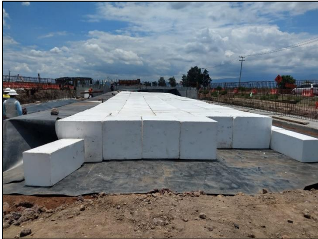
Figuras 9 y 10. Proceso de instalación de los bloques EPS cubiertos con geomembrana HDPE.
