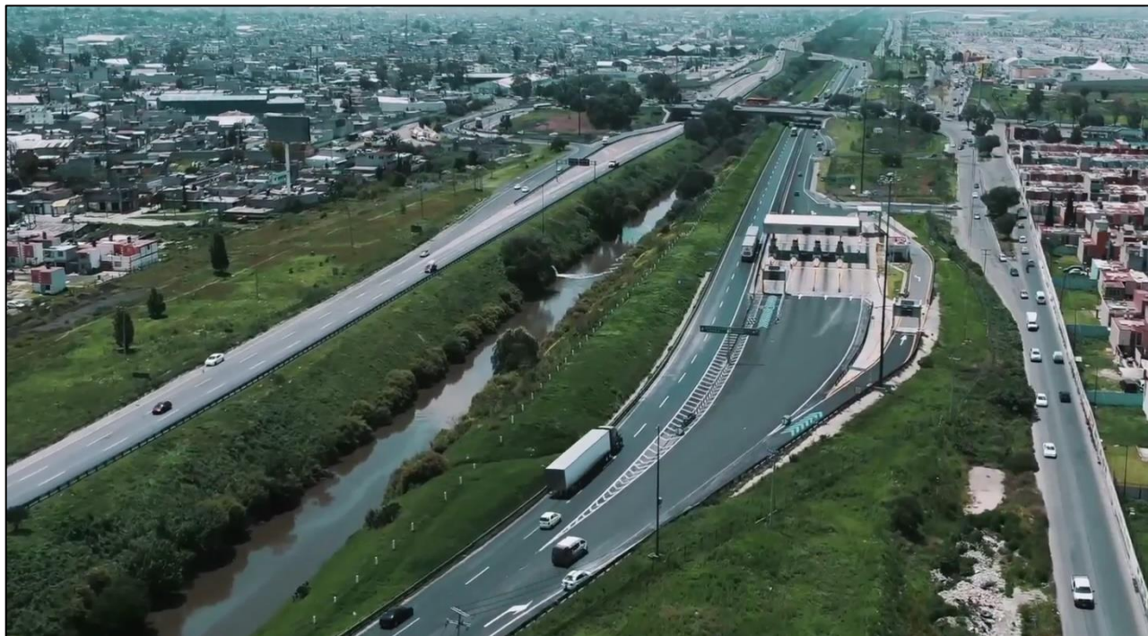
Figura 9. Carretera Pirámides – Texcoco finalizada y en funcionamiento (GRUPO TDM, 2018)
