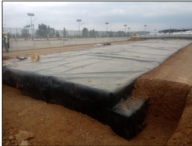
Figuras 11 y 12. Proceso de instalación de los bloques EPS cubiertos con geomembrana HDPE.
