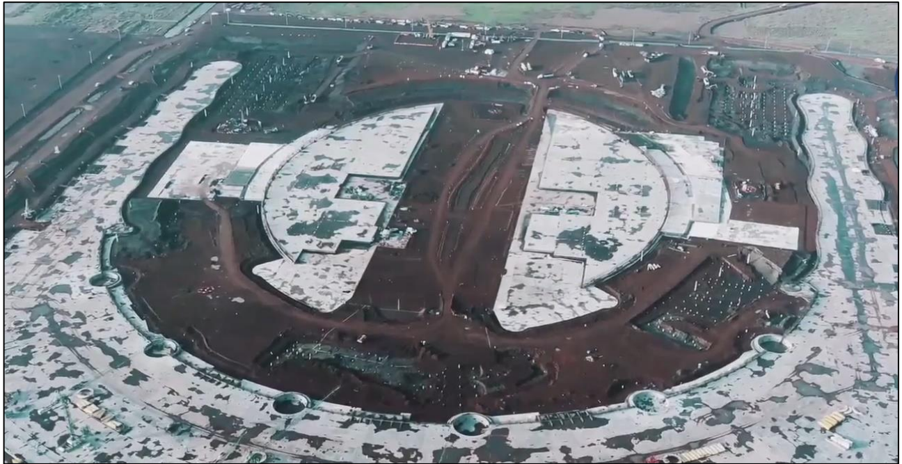
Figura 5. Vista aérea de los trabajos en el CTT (GRUPO TDM, 2018)
