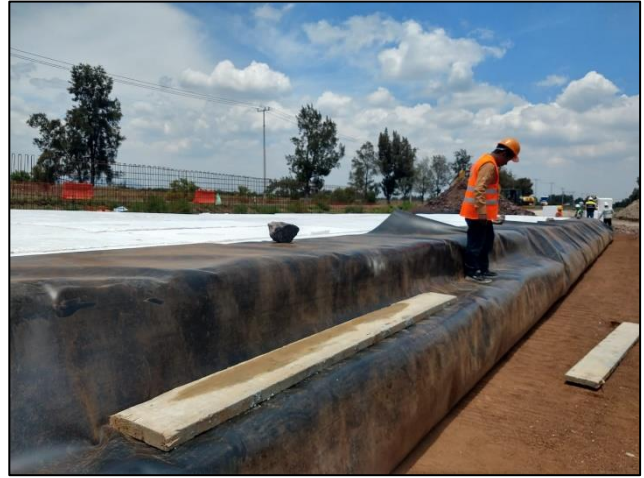
Figuras 9 y 10. Proceso de instalación de los bloques EPS cubiertos con geomembrana HDPE.
