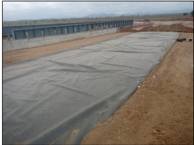
Figuras 11 y 12. Proceso de instalación de los bloques EPS cubiertos con geomembrana HDPE.
