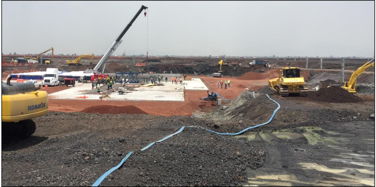
Figura 7. Geomalla instalada en el sector de la losa del edificio terminal (GRUPO TDM, 2018)
