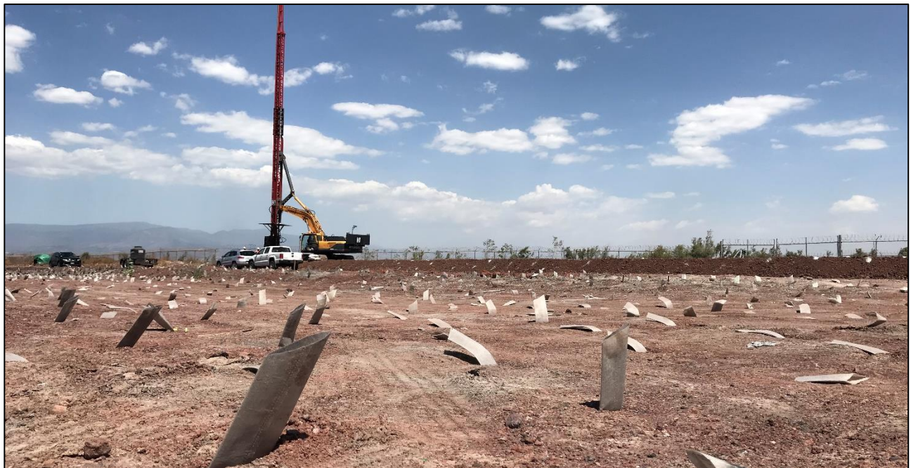
Figura 6. Mechas drenantes instaladas en el sector de las pistas de aterrizaje y despegue (GRUPO TDM, 2018)
