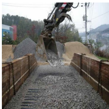
(c) Place the fill layer
