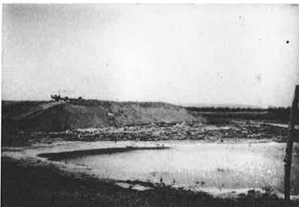
Fig. 5 - Vue d'ensemble de l'ouvrage et bourrelet de pied
