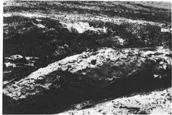
Fig. 6 - Rupture localisée du remblai dans la zone volontairement sous-dimensionnée
