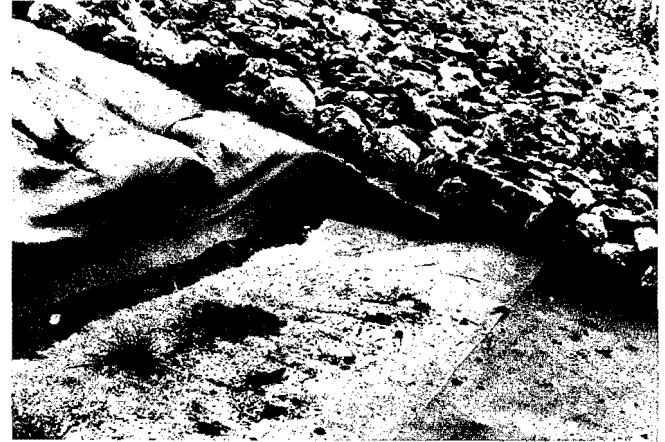
Fig. 7 - Réparation de la zone B. Le textile, découpé de manière à épouser la forme de la berge, a été ensuite recouvert d'une autre nappe de textile, puis de blocs. Au deuxième plan, on remarque le parfait comportement de la zone C
