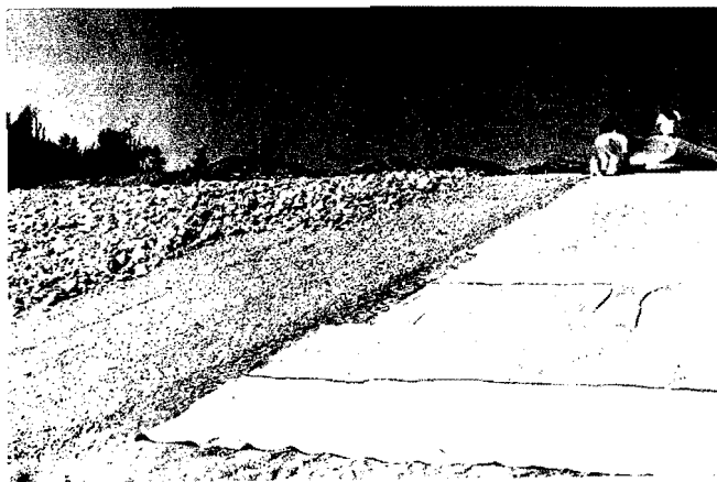
Fig. 4 - Vue des zones A et B de la protection amont pendant la construction. A gauche, zone A : blocs et graviers (qui ont été, ensuite, recouverts de blocs). A droite, zone B : nappe textile formée de lés cousus entre eux et clouée au sol
