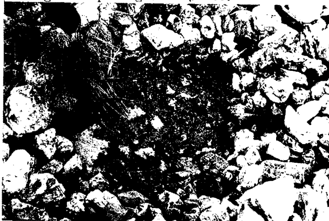
Fig. 11 - Parement amont : dégagement du textile sous enrochement ; remarquer la propreté du textile à l'emplacement des blocs
