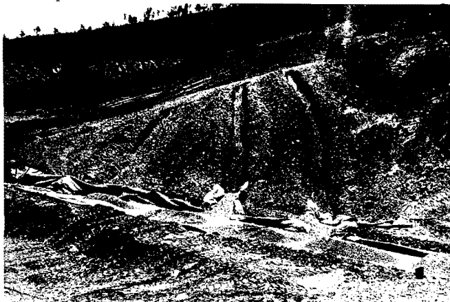
Fig. 2 - Drain aval : vue d'un collecteur et de trois tranchées. Ces tranchées ont été ensuite revêtues de textile et remplies de gravier, comme le collecteur. Ensuite collecteur et tranchées ont été recouverts de textile et le tout a été recouvert par la terre compactée constituant la partie aval du barrage
