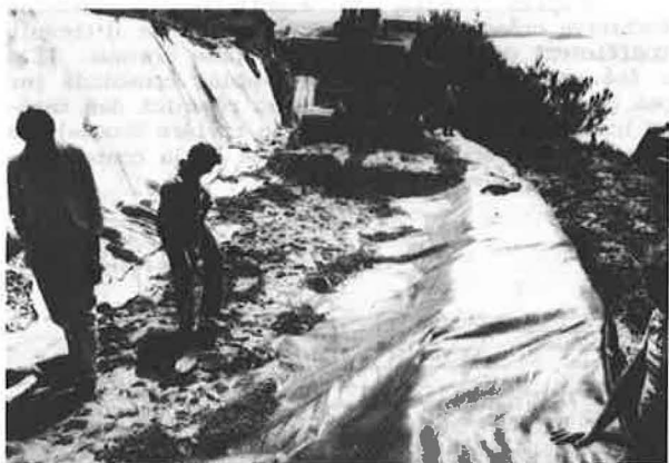
photo 6 : Mise en oeuvre : la nappe de renfort enveloppe les conteneurs-cube qui servent de coffrage-parement
