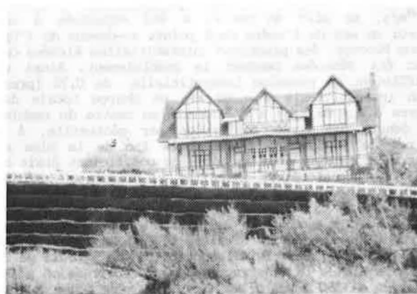
photo 7 : Ouvrage de Trouville-sur-Mer : vue générale
