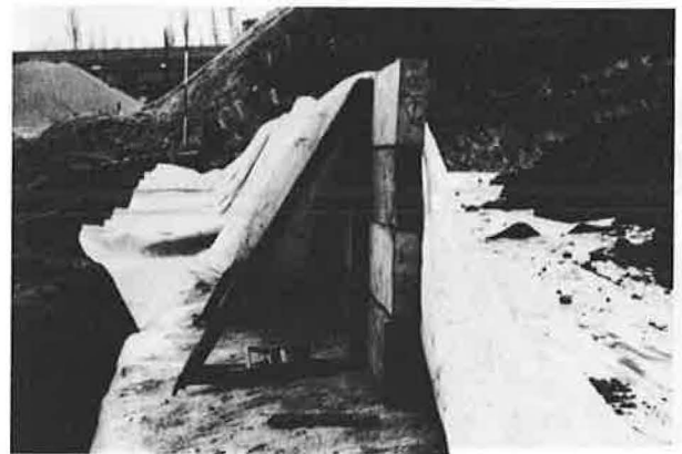
photo 3 : Coffrage mobile ancré au remblai par sangle textile (Parement incliné)
