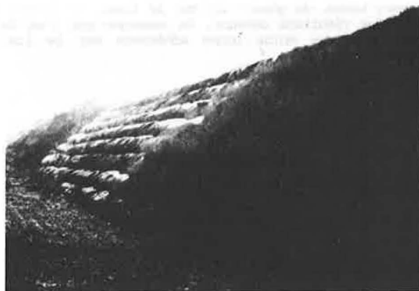
photo 1 : Ouvrage de Rouen : parement incliné à 45°
