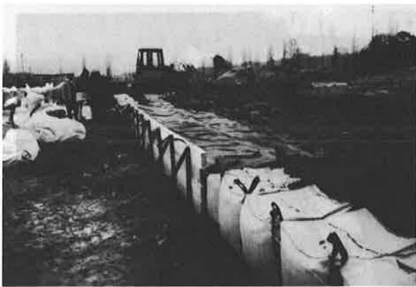
photo 5 : Coffrage parement : conteneur cube
