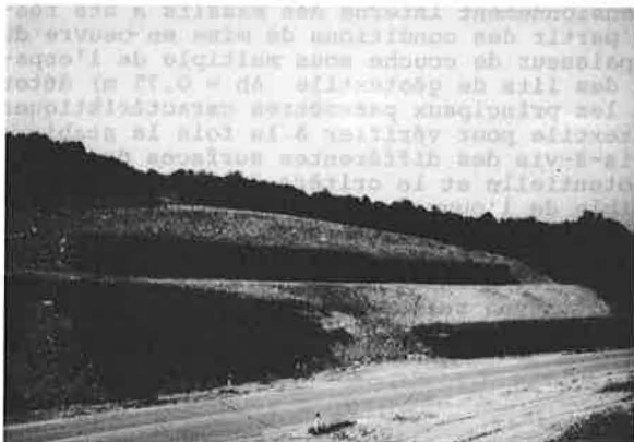
Fig. 4 - Vue d'ensemble du site après confortation
