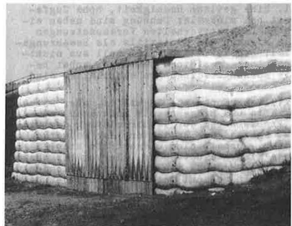
Abb.4 Fertiggestelltes Experimentalbauwerk mit teilweise lichtgeschützter Außenhaut
