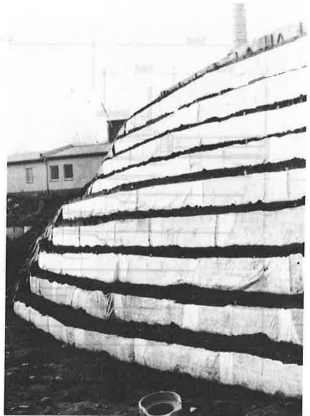
Abb.10 Ansicht der Außenhaut der übersteilen Böschung während des Bauzustandes
