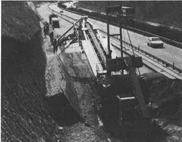
Figure n° 11 - Vue du chantier montrant l'extrémité d'une section en construction
