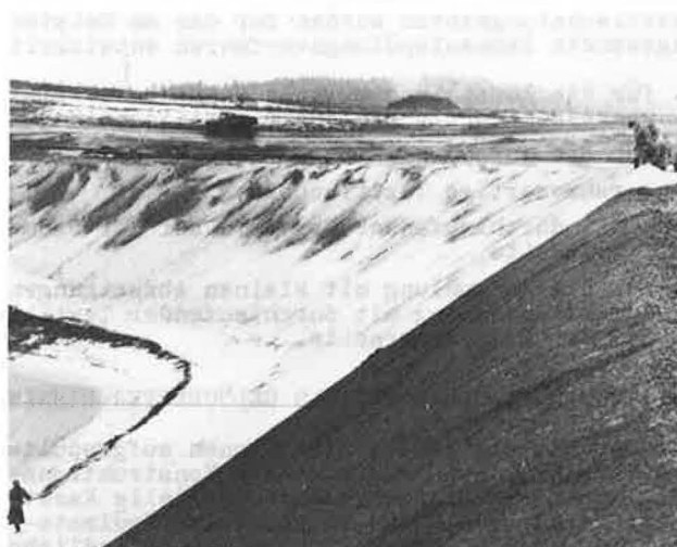
Abb. 4 Verlegen der Geotextilie auf den Damm des Absetzbeckens
