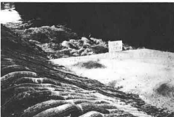
Vue partielle du canal situé en amont du premier seuil
