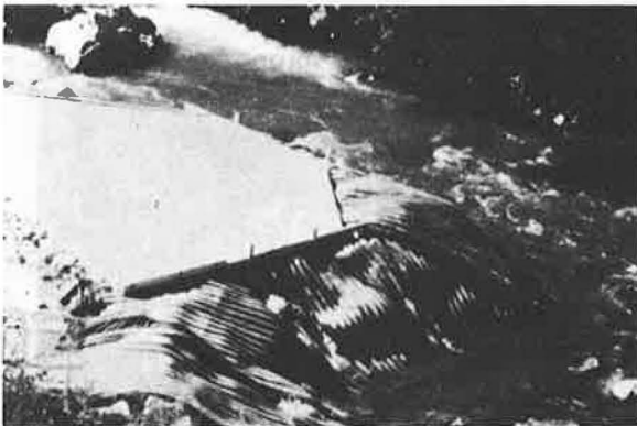
Vue du premier seuil réalisé
