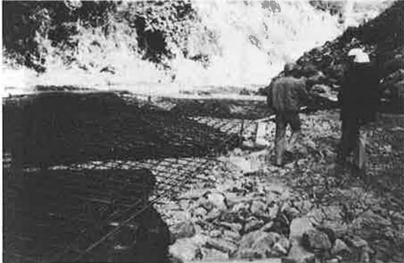
Ancrage du sommet des nappes "COFRABETEX" dans l'armature d'une dalle en béton armé
