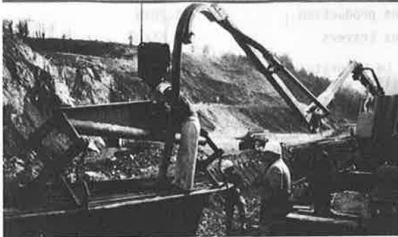
Vue du palonnier et de la nappe "COFRABETEX" pendant le remplissage
