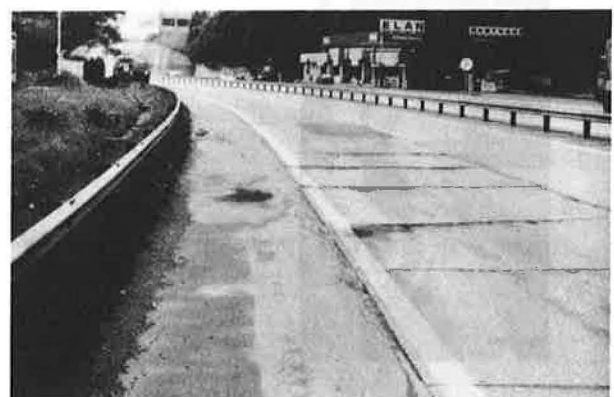
Bild 2: Stufenbildung am LKW-Fahrtstreifen
