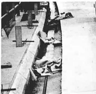
Bild 4: Seitliche Entwässerung zwischen den Einlaufschächten auf Brücken durch Drainagen mit Vliesabdeckung
