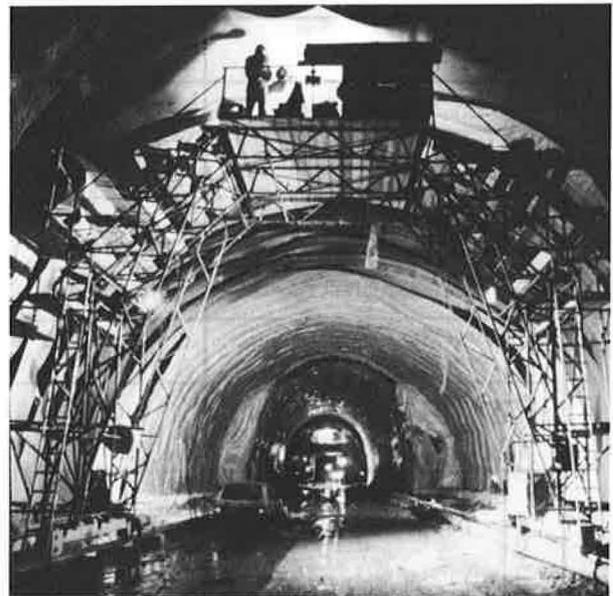
Abbildung 1: Flächenabdichtung in einem Straßentunnel mit Schutzschichte und PVC-Dichtungsbahn
