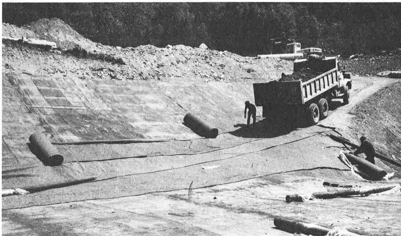
Vue 3 - Application du géotextile anti-poinçonnant sur la géomembrane et apport du remblai.
