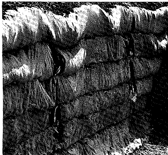
Fig. 10 - Détail à la fin du déblaiement.
