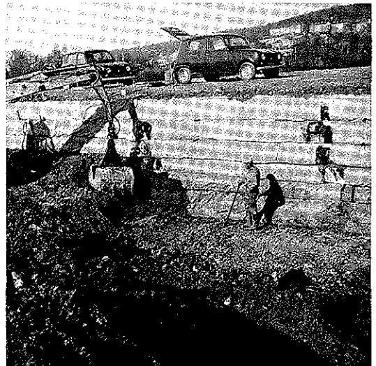
Fig. 8 - Découverte du mur. L'opération de déblaiement est effectuée à la pelle, puis à la main à partir de 50 cm du parement pour éviter de le dégrader.
