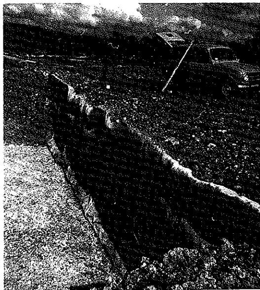
Fig. 9 - Vue générale du mur après le déblaiement (20 Avril 1971).
