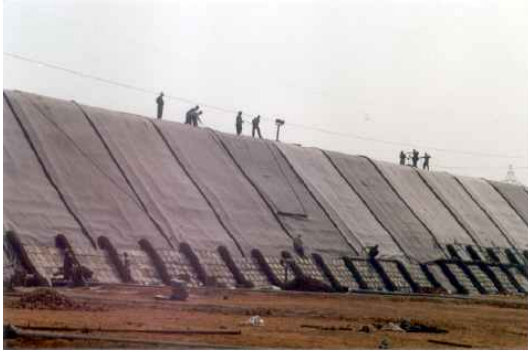
Geomembrane Installation
