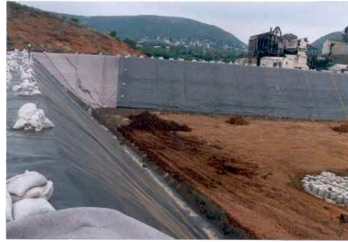
Geomembrane Installation
