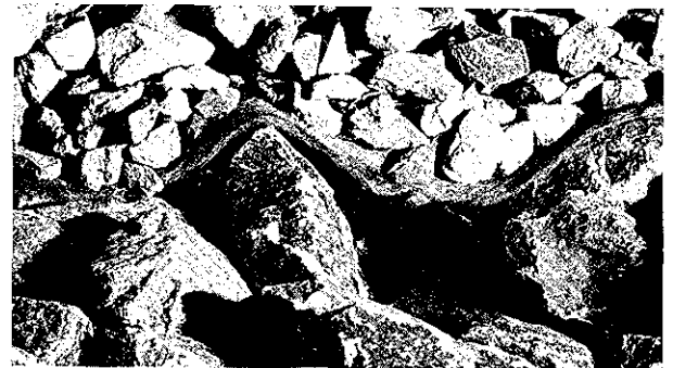
Fig. 8. Aspect du géotextile épousant son support.
