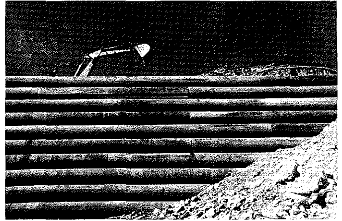
fig 11 Premier ouvrage réalisé en Terre Armée (PRAGNERES)
