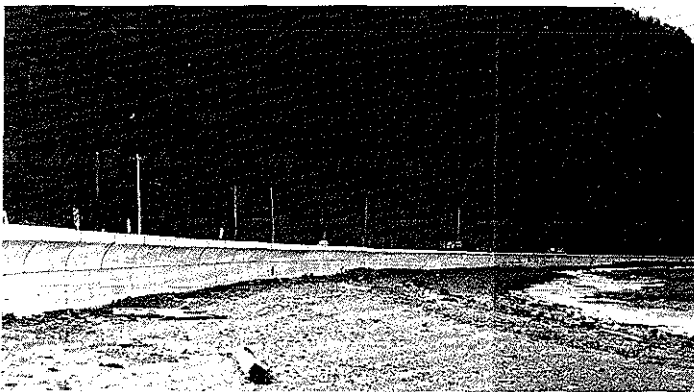
Fig. 2- Mur de Mont St-Pierre
