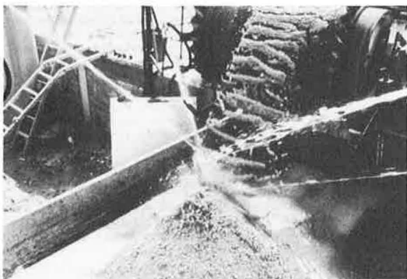
Figure 1 - Premiers essais en vraie grandeur en 1979. Les fils sont projetés par des jets d'eau.
