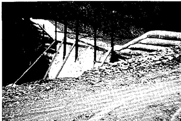
Il est bien évident que dans le cas d'un ouvrage déversant sur fondation meuble ou rocher pouvant facilement se déliter, il serait obligatoire de prévoir un véritable parafouille et un bassin de dissipation d'énergie en béton armé ayant par exemple une forme en auge.
